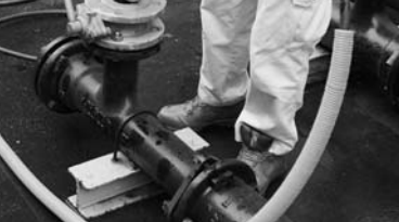
T字管から洗浄ヘッドを挿入
