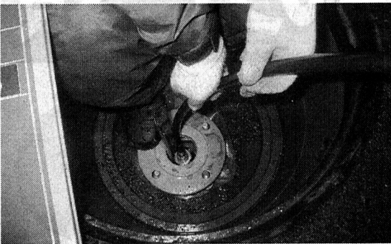
洗浄ヘッドの挿入状況
