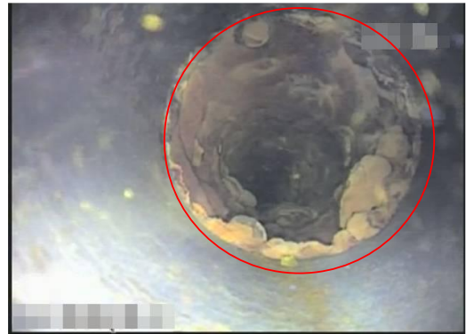
●図表 1-2-13 異形管内面の錆こぶ
