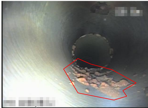
●図表 1-2-12 管底の堆積物（錆など）
