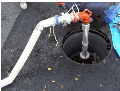
●図表 2-1-1 排水洗管作業
