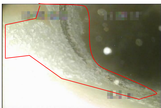
呼び径 150 昭和 44 年布設
